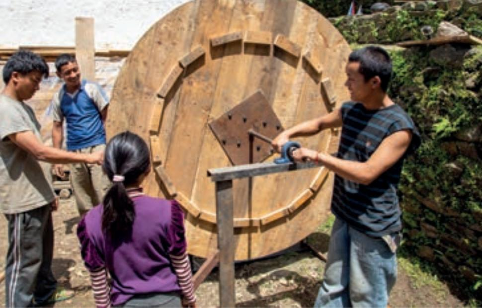
Aufbau und Installation einer Pilotanlage aus Holz, zusammen mit Einheimischen, zur Erprobung der Machbarkeit des Projekts.
